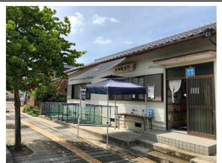
助成金で補修した元田集会所
